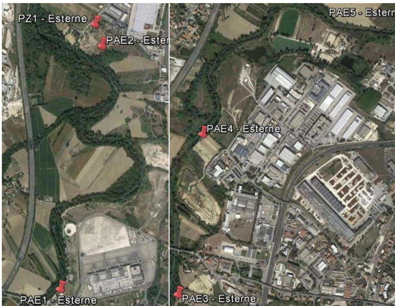
Figura 12 – Perforazioni Aree esterne
